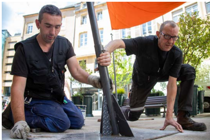
Vincent ZULIANI et Philippe GLIEDNER DEPU, Equipements, Voirie et Réseaux
