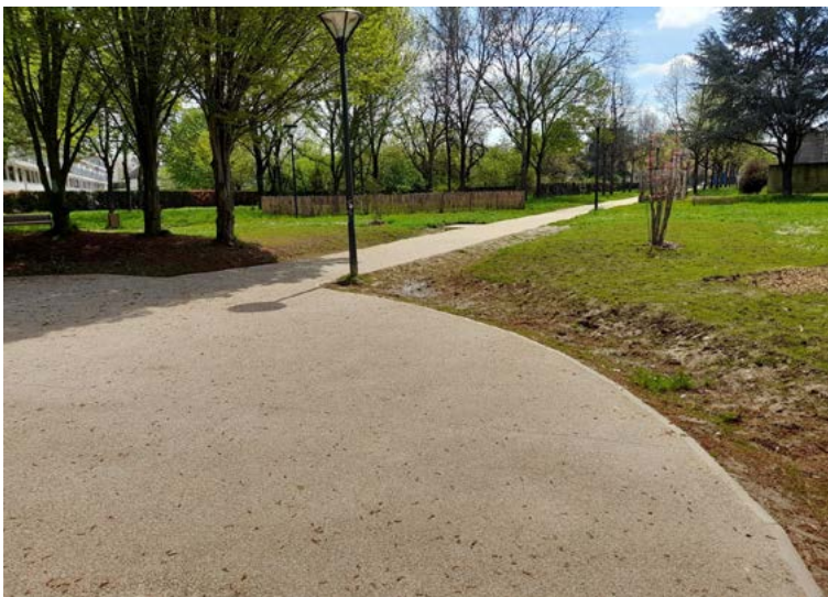
Réfection des allées - Parc Nelson Mandela (tranche 2)
