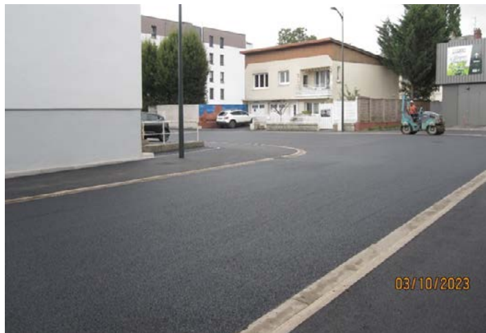
Requalification de la voirie - rue du Commandant Sigoyer et impasse Ermesinde
